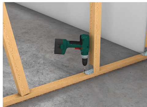
Montage af underkonstruktion i træ.
