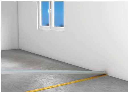
Montage af stålfiler i top- og bundskinne af stål.
