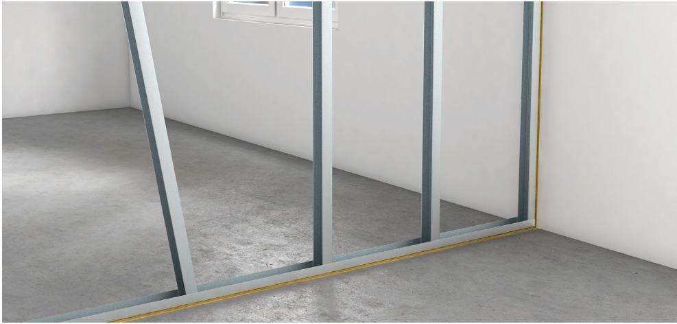
Montage af CW-stålsprofiler.
