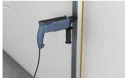
Fastgørelse af C-profiler på væggene med en lydisolierende filt- eller mineraluldsstrimmel.
