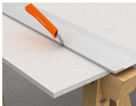
Step 1 - Ridsning og knækning.
