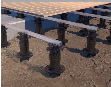
Udvid terrassefundamentet med Flexi jordspyd.
