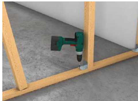
Montage af underkonstruktion i træ.
