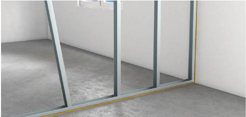
Montage af CW-stålsprofiler.
