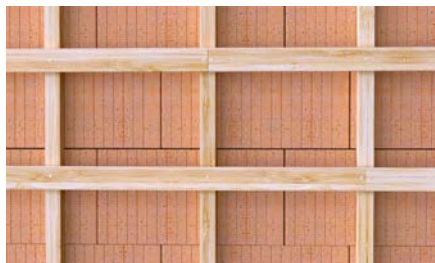
Underkonstruktion i tømmer
